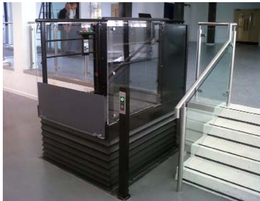
Uitvoering met vol glaspaneel in de railing en volglas in de draai-poort. De lift is in kleur in combinatie met luxe bedienings tableaus.
